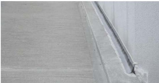
Integración en ángulo con pieza moldeada prefabricada.
