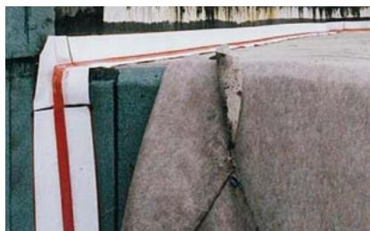
RedLINE se aplica a presión directamente sobre el hormigón con cola de resina epoxi.
